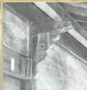
⑦持ちおくり 下屋根を支えるもので、塩飽大工の腕を競うように、凝った彫刻のものがあります。
